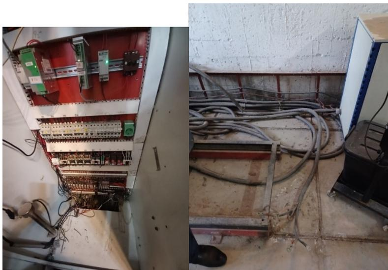
۴۹- سیستم‌های ایمنی بایستی با کلیدهای سوئیچ دار و یا معادل آن در مقابل تغییرات غیرمجاز (Unauthorized manipulation) محافظت شوند، که نظر به وجود مکانیزم الکترونیکی، اجرای یک سیستم معادل نظیر قفل گذاری (Password) بخش تنظیمات اصلی پیشنهاد می شود (بندهای ۶-۲-۳ و ۶-۲-۵ استاندارد ۱۱۳۵۵).
