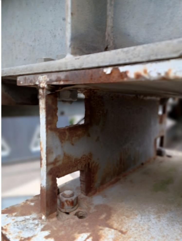
۳- خوردگی و زنگ زدگی پیچ‌های اتصال دهنده قطعات ستون‌ها که بایستی با رعایت گرید مناسب جایگزین شوند (بند ۳-۱۱-۳ استاندارد ۱۱۳۵۶).
